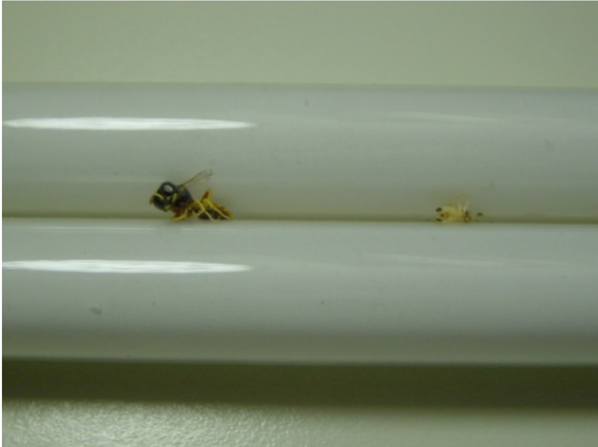
Bild 3 Tote Insekten in einer Kompaktleuchtstofflampe (Bild ERGONOMIC)
